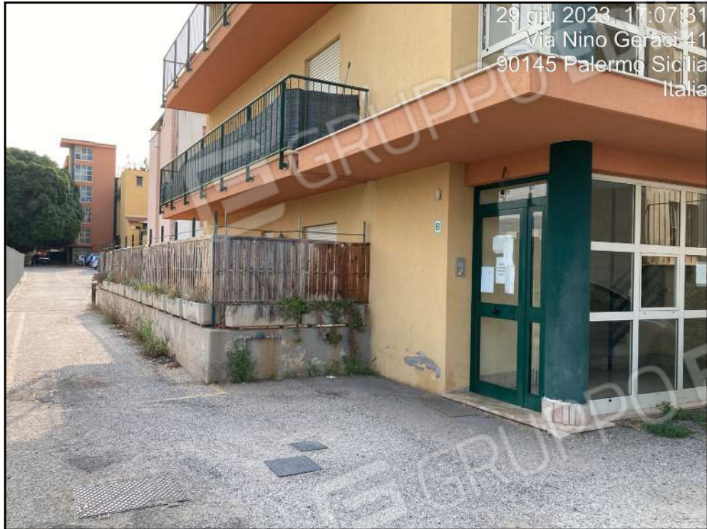
Foto n. 9 - Vista esterna Edificio Scala B
