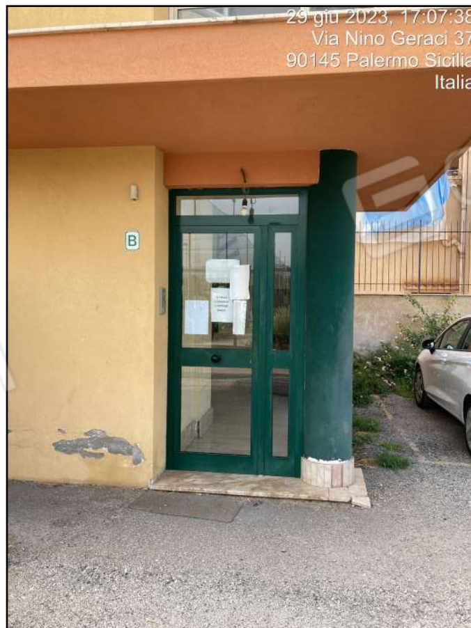
Foto n. 10 - Vista esterna Edificio Scala B
