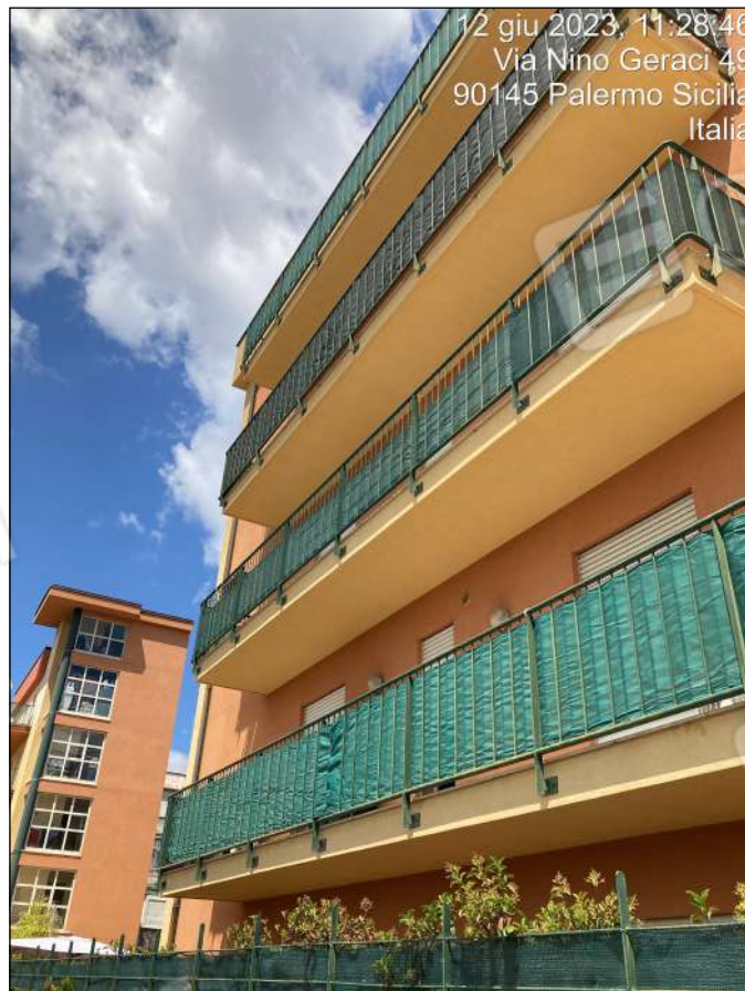
Foto n. 8 - Vista esterna Edificio Scala C
