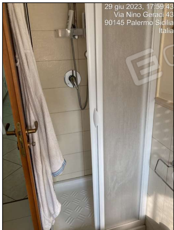
Foto n. 18 - Interni: w.c. con doccia
