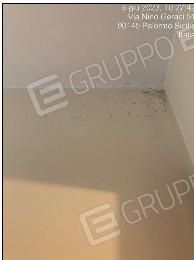
Foto n. 23 - Interni: w.c. con doccia - dettaglio condensa sul soffitto
