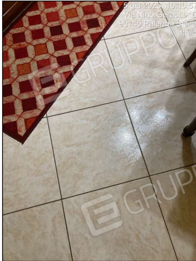
Foto n. 15 - Interni: dettaglio pavimentazione
