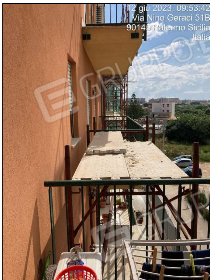
Foto n. 25 - Interni: balcone della cucina
