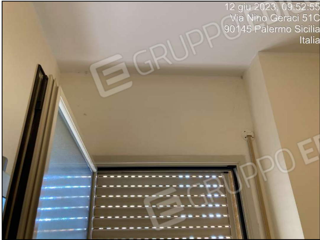
Foto n. 23 - Interni: segni di umidità da condensa nel w.c. doccia
