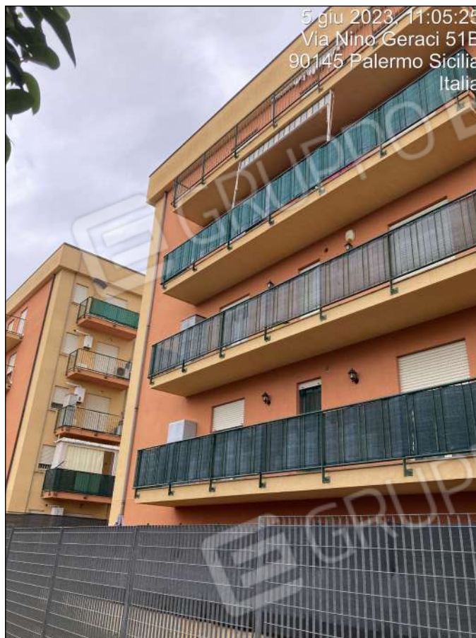
Foto n. 7 - Vista esterna Edificio Scala D
