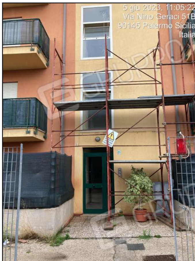
Foto n. 9 - Vista esterna Edificio Scala D
