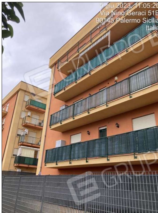
Foto n. 7 - Vista esterna Edificio Scala D
