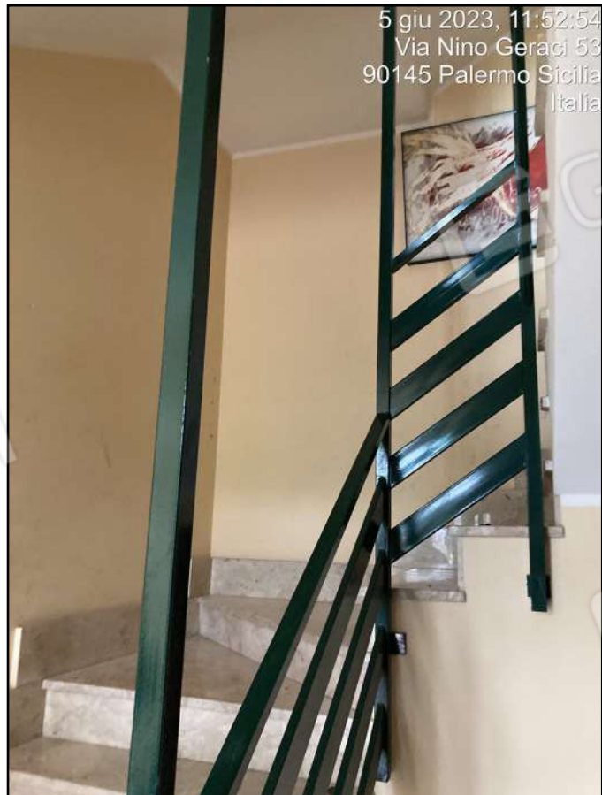
Foto n. 10 - Corpo scala Scala E
