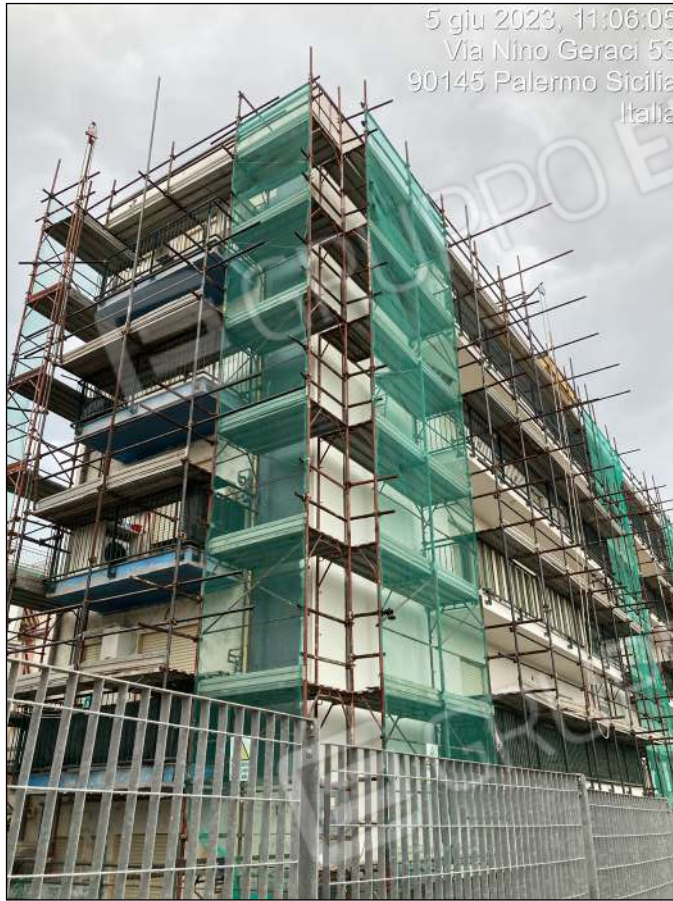
Foto n. 7 - Vista esterna Edificio Scala E
