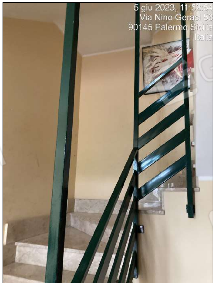
Foto n. 10 - Corpo scala Scala E
