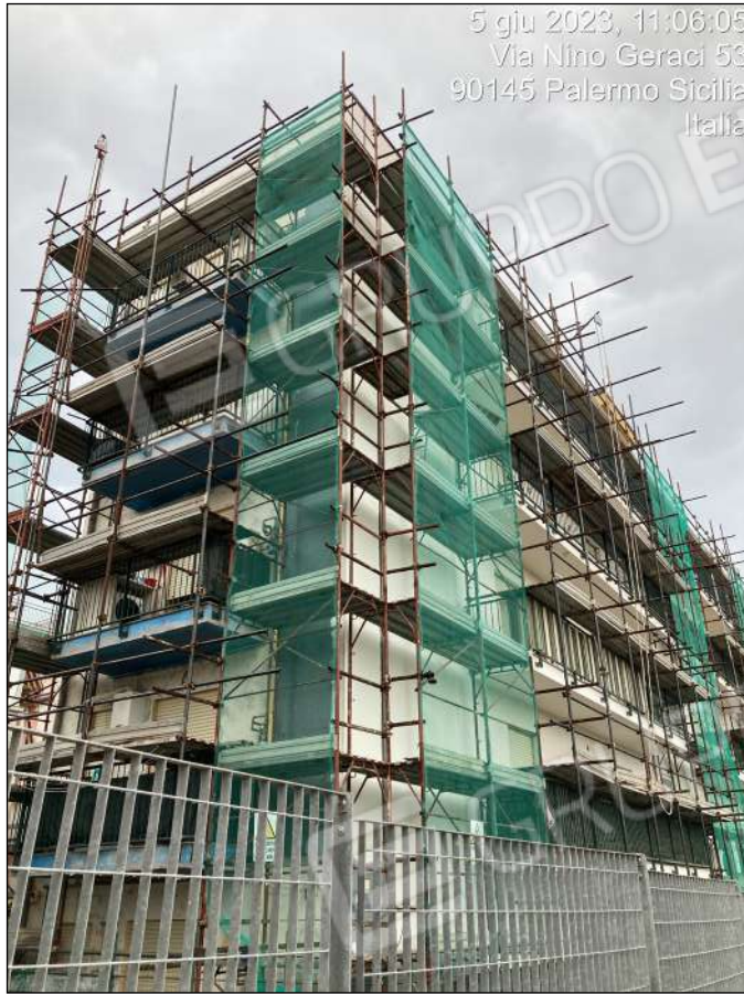
Foto n. 7 - Vista esterna Edificio Scala E
