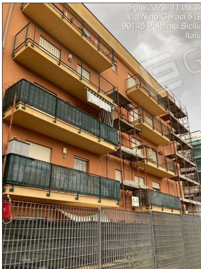
Foto n. 8 - Vista esterna Edificio Scala D
