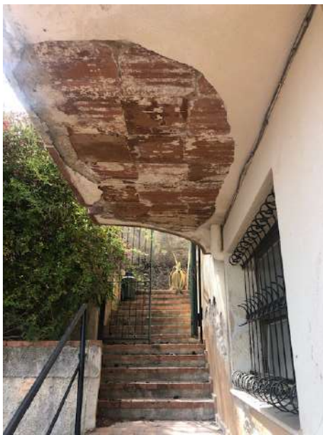
ammaloramento del sotto balcone e del terrazzo n. 1
