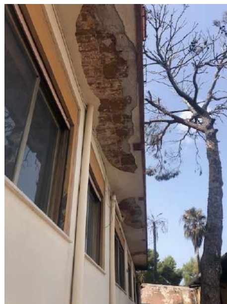
ammaloramento del sotto balcone e del terrazzo n. 1
