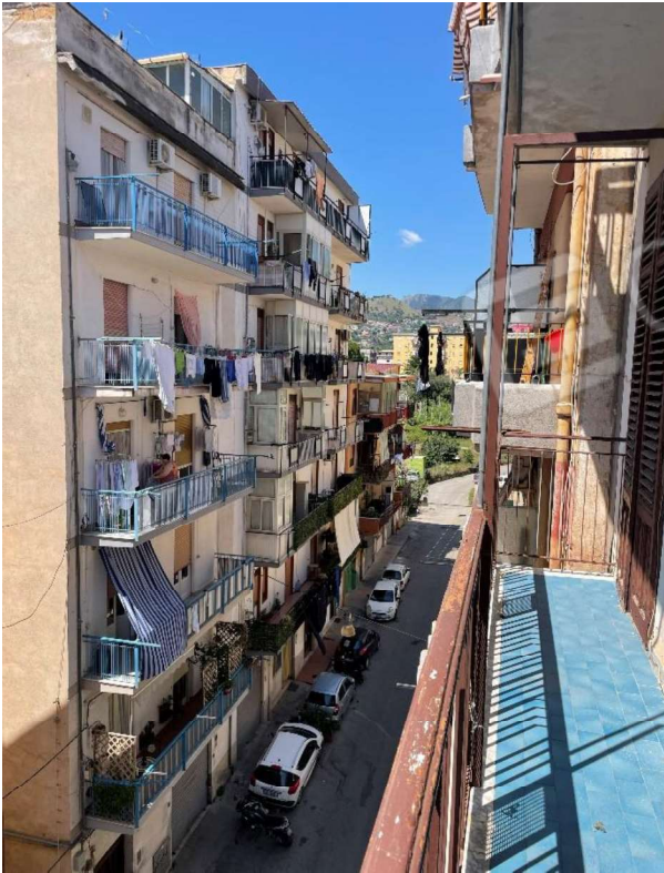
Foto 17 – Veduta su strada dal balcone su via Ustica
