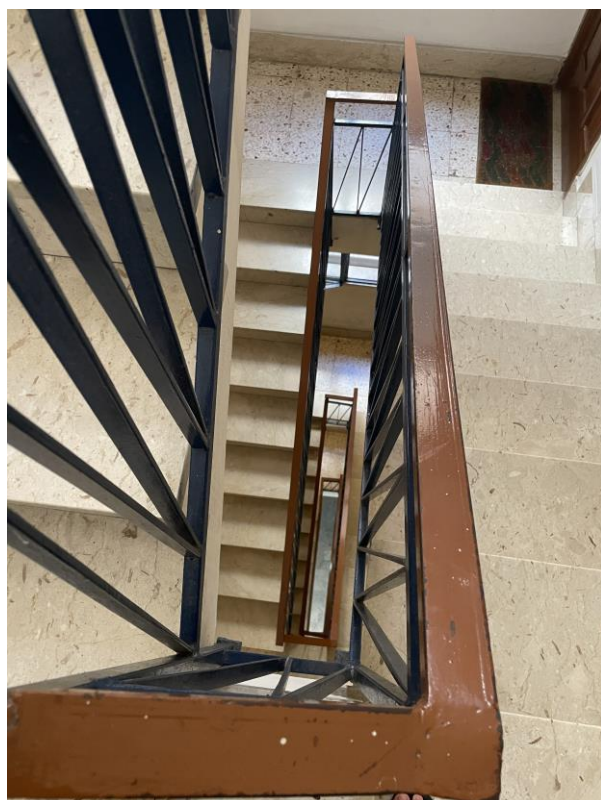
Foto 3 – Il vano scala senza ascensore
