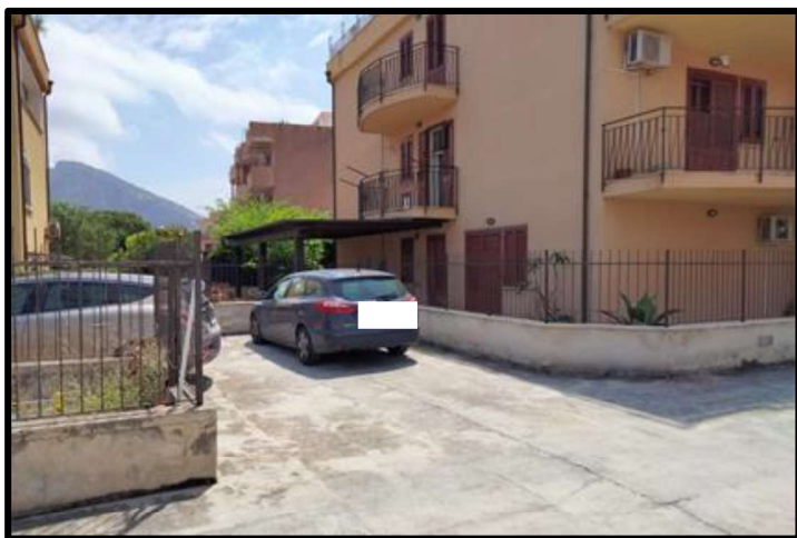
Foto n°15 – Vista esterna dell'area condominiale a posto auto.
