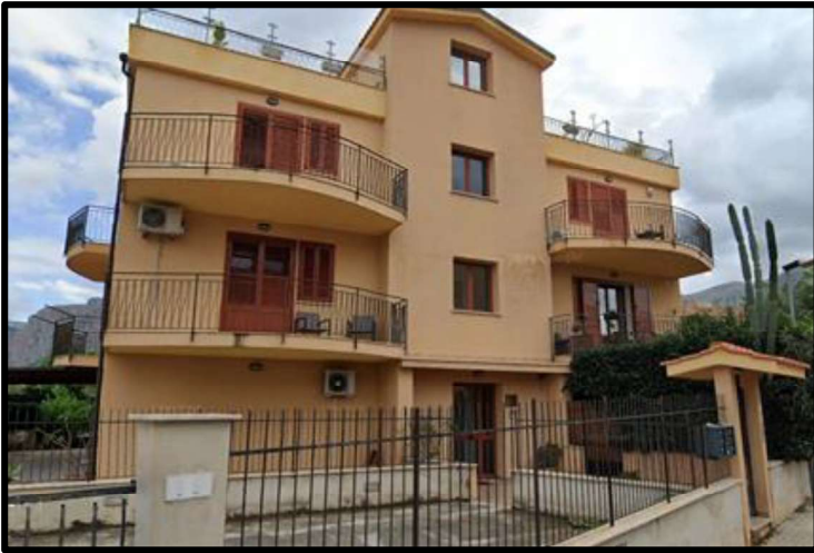
Foto n°3 – Vista dell'ingresso Condominiale.
