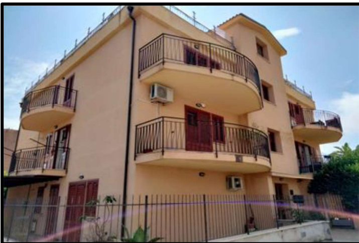
Foto n°2 – Vista del fabbricato.
