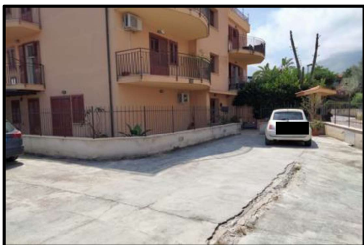
Foto n°16 – Vista esterna dell'area condominiale a posto auto.
