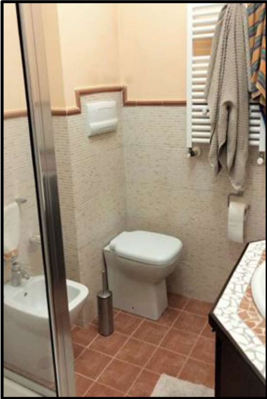
Foto n°8 – Vista interna del bagno.
