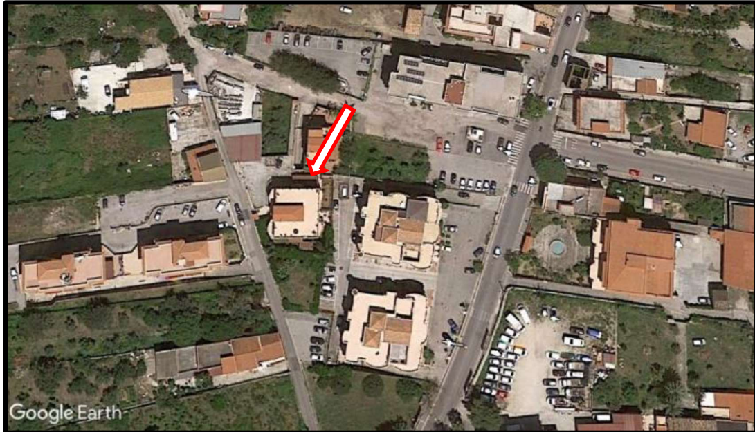
Foto n°1.- Vista aerea del fabbricato e struttura viaria.
