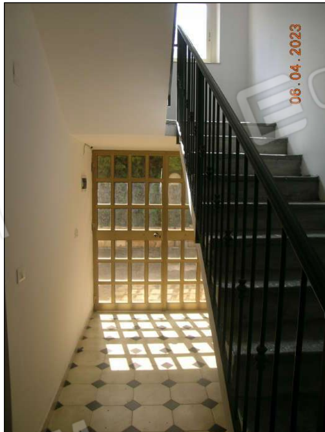
Androne e vano scala
