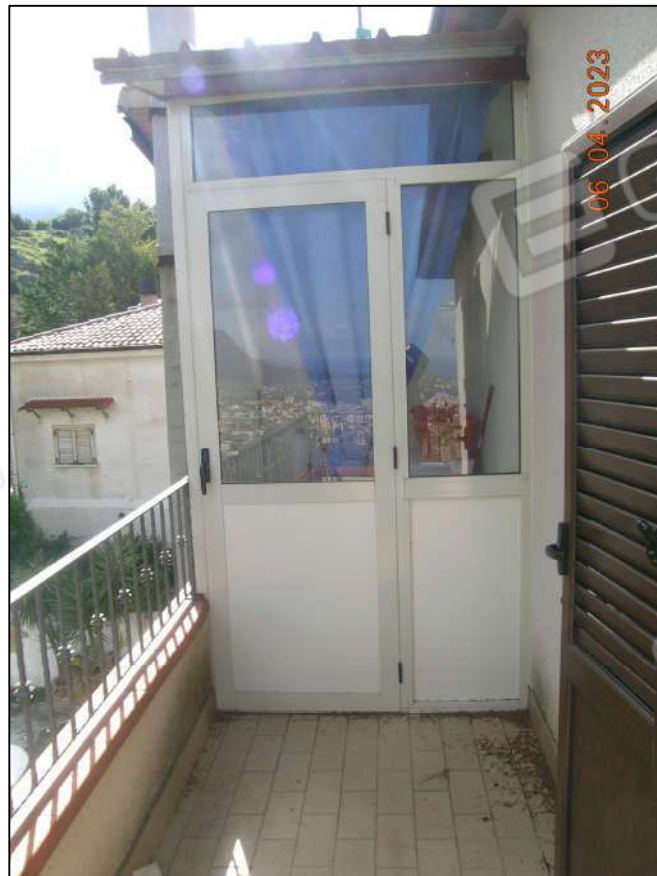
Vano lavanderia nel balcone su fronte sud
