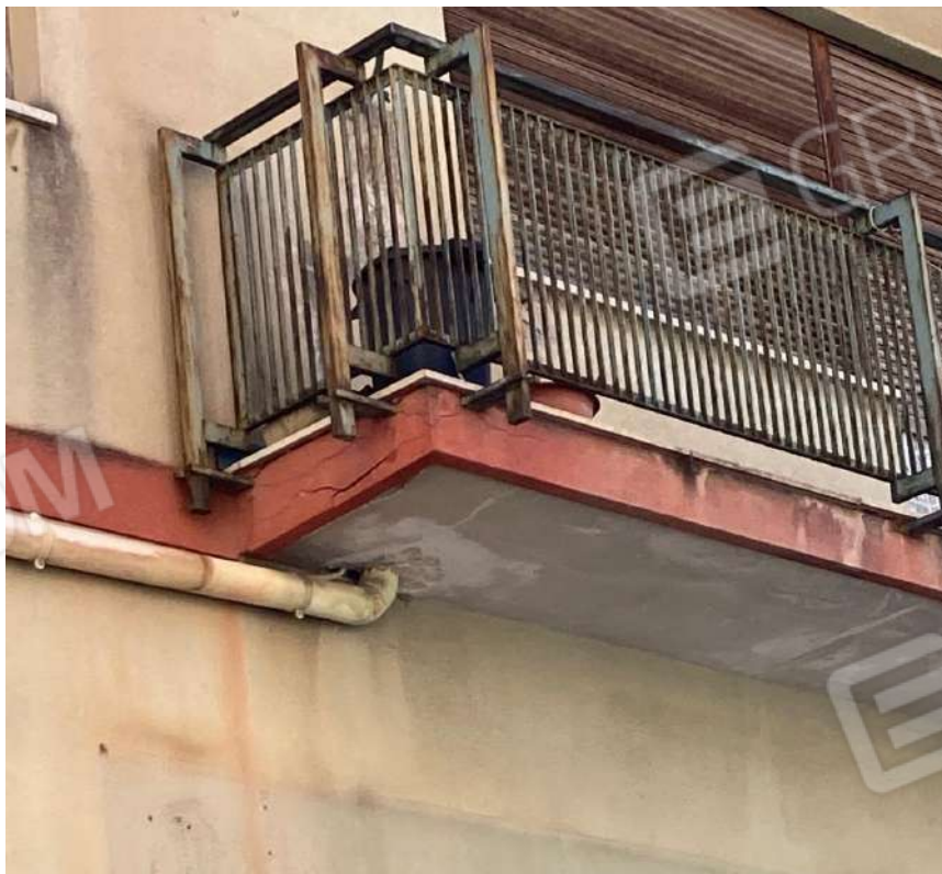
DETTAGLIO INTRADOSSO BALCONE PIANO PRIMO PROSPETTO SU VIA BUONARROTI
