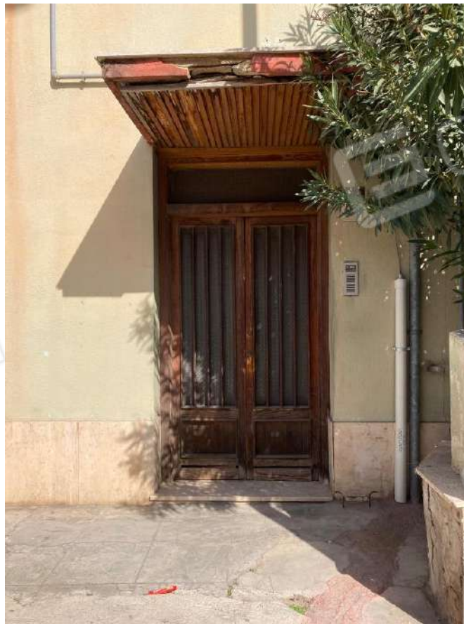
PORTONE INGRESSO AL FABBRICATO CORSO VITTORIO EMANUELE 584
