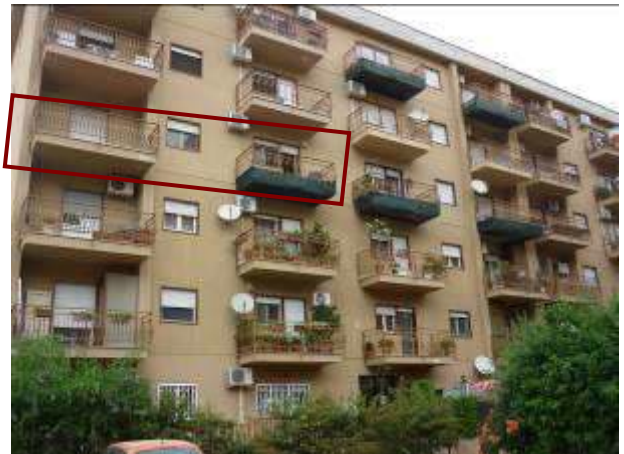
FOTO 6 SCALA A CONDOMINIO VIA DEL LEVRIERE N. 103
