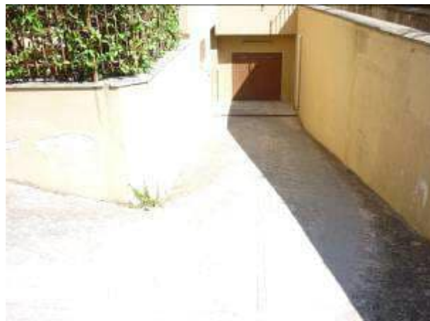
FOTO 10 RAMPA DI ACCESSO AL PIANO SEMINTERRATO
