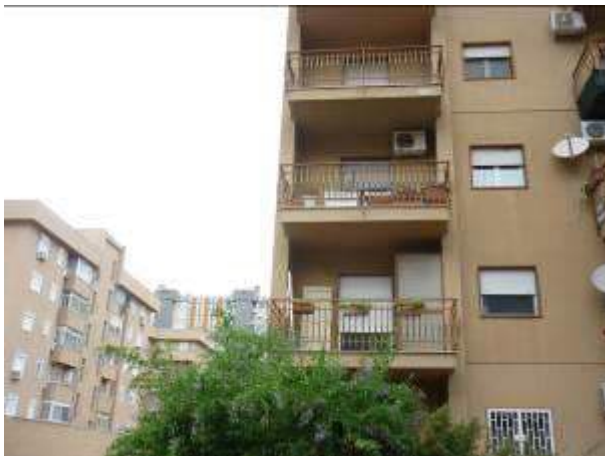
FOTO 7 SCALA A CONDOMINIO VIA DEL LEVRIERE N. 103
