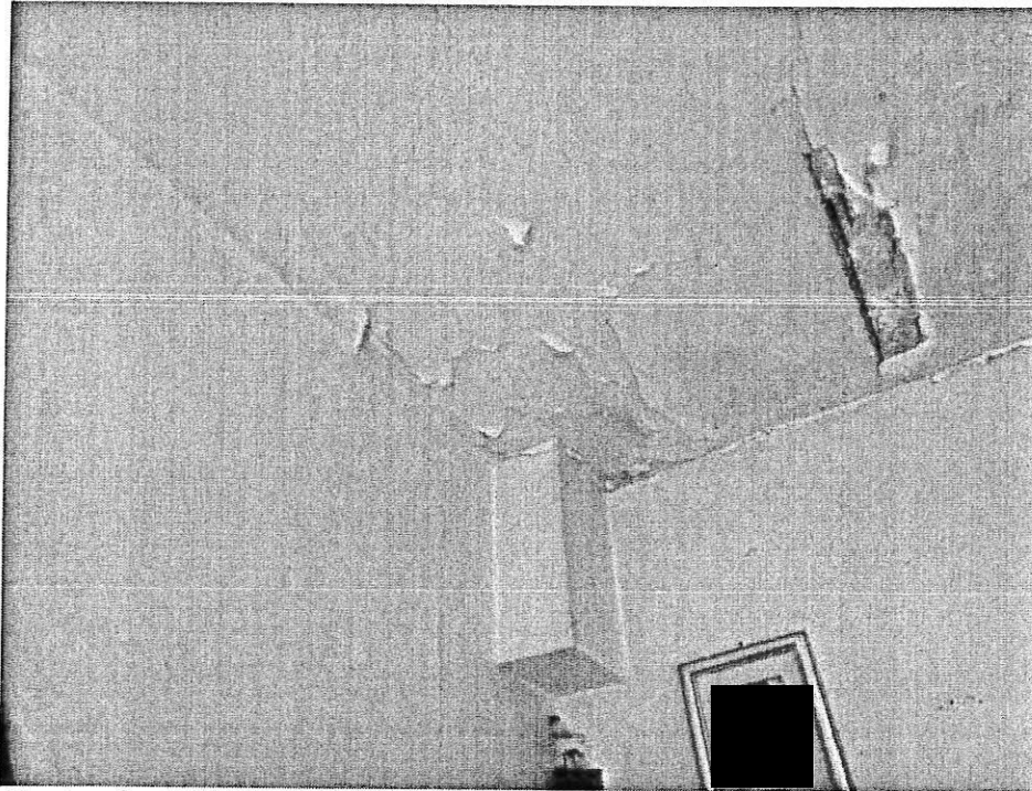
Illustrazione 7: cavedio contenente la tubazione fognaria condominiale
