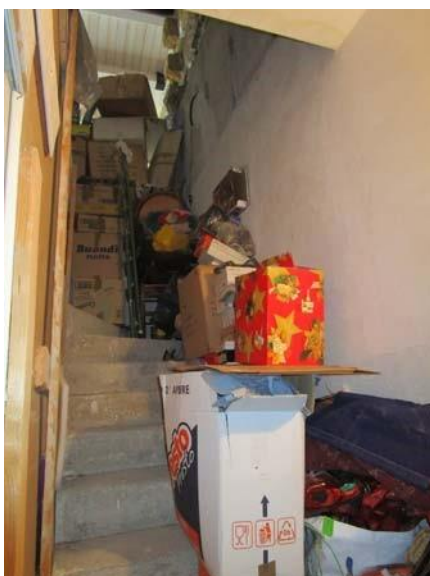
17.SCALA DI ACCESSO AL SOTTOTETTO
