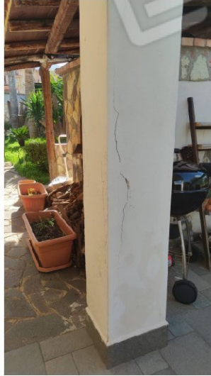
Fig.20-21-22 distacchi dell'intonaco e fessurazioni nei pilastri del porticato
