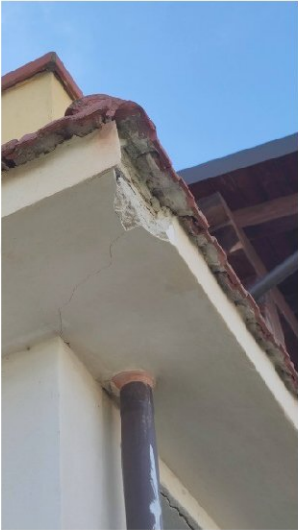
Fig.20-21-22 distacchi dell'intonaco e fessurazioni nei pilastri del porticato
