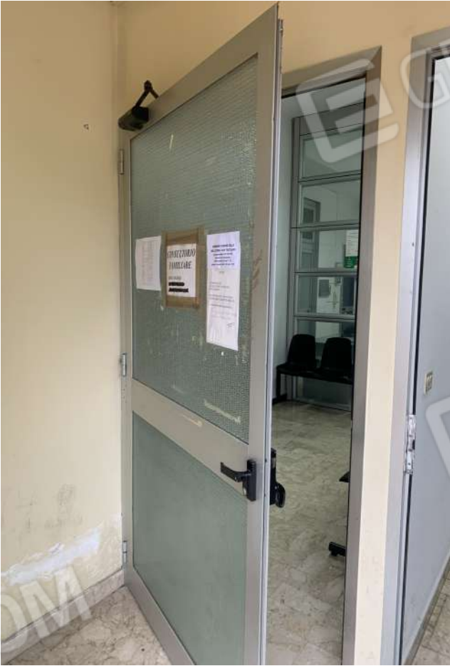
Foto 15 Ingresso di sinistra sul prospetto nord
