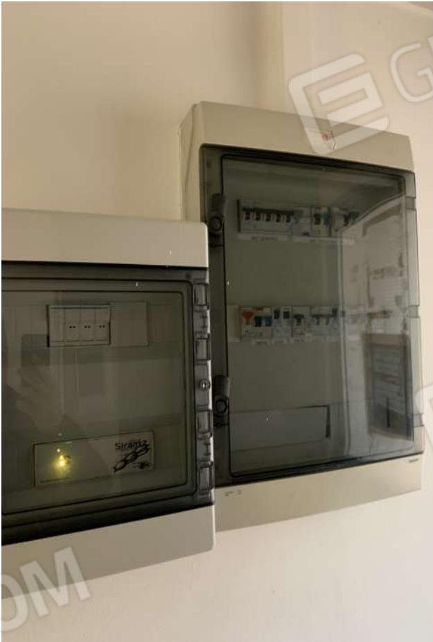
Foto 27 - 28 Il quadro elettrico generale
