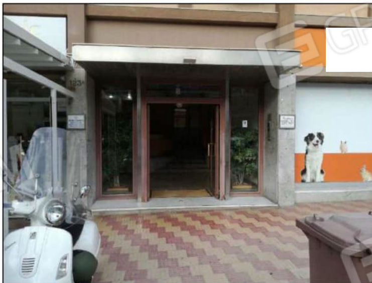
Foto 5 – Vista Condominio via Serradifalco n. 123
