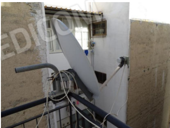
Parabola nel balcone sul prospetto posteriore-
