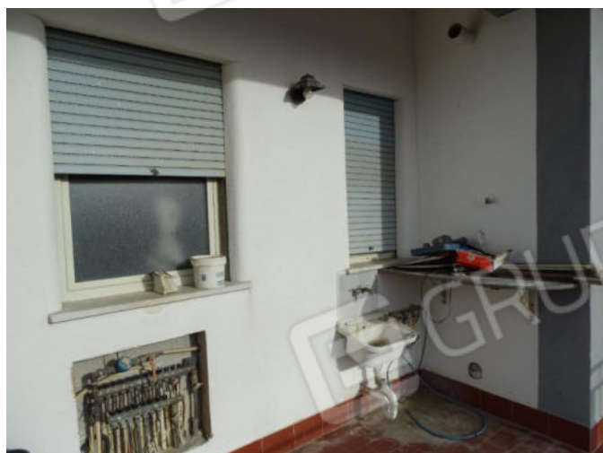
Balcone su prospetto principale
