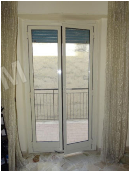
Particolare di un infisso in alluminio e vetro camera.
