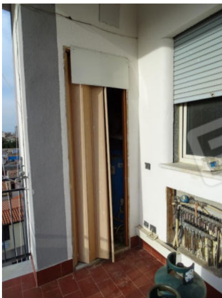
Ripostiglio nel balcone su prospetto principale
