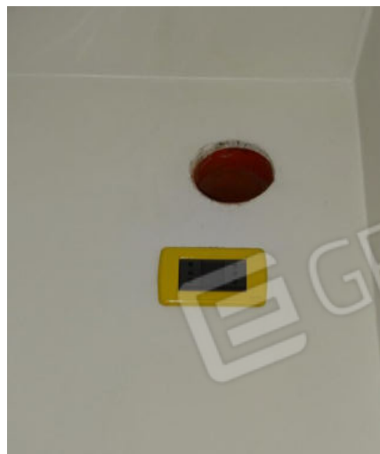
Locale wc/lavanderia . Predisposizione aerazione forzata
