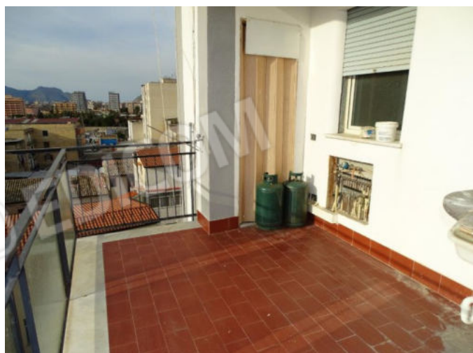
Balcone su prospetto principale
