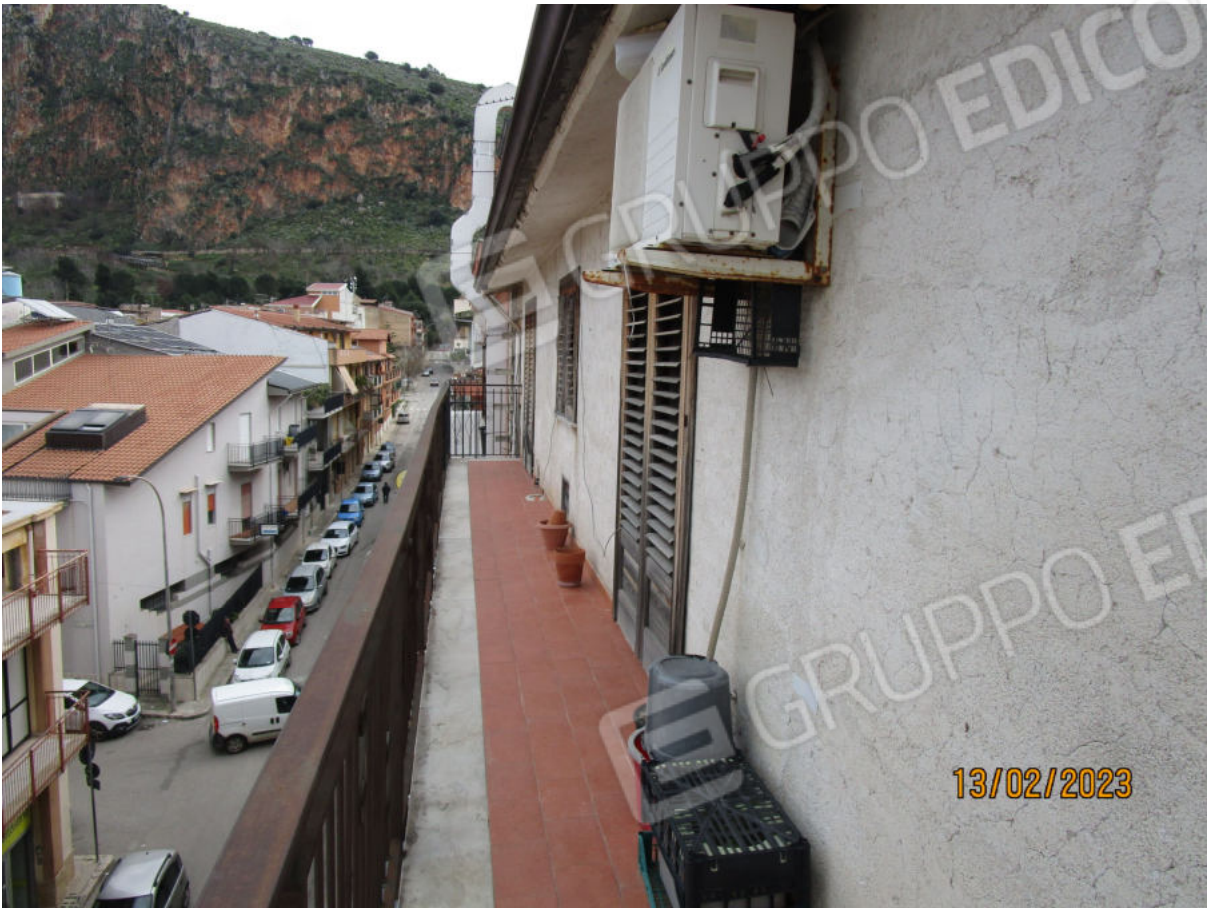
Foto 19 – Balcone su via Taranto
