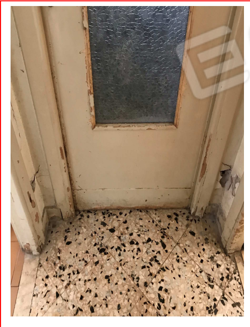
Foto n°28: Serramenti e infissi interni dei w.c. e della cucina.
