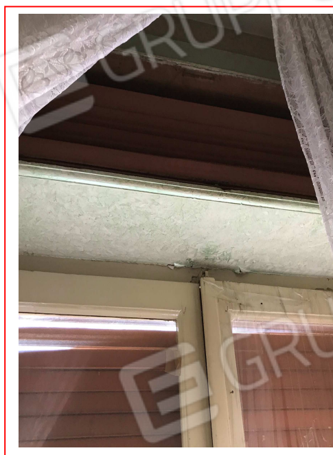
Foto n°27: Sportello del cassone avvolgibile vano 2.
