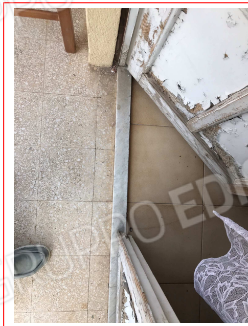
Foto n°25: Serramento esterno del vano Cucina esposto su retroprospetto.
