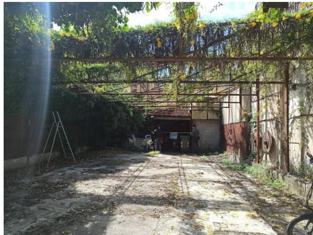
Si tratta di un capannone in ferro e vetro totalmente arrugginito e inutilizzabile, di cui resta in piedi solo la struttura portante, coperta da vegetazione, poggiato su un battuto di cemento, che occupa un'area di circa 148 mq. In fondo è visibile un piccolo manufatto precario in muratura, non presente nella planimetria catastale, di cui si prevede la messa in pristino.
