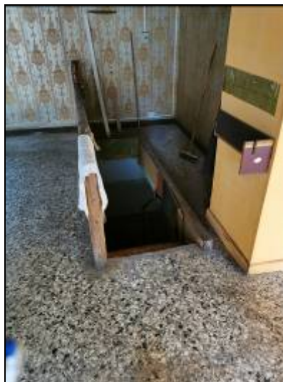
Scala di collegamento con il sottostante magazzino (sub. 31)
