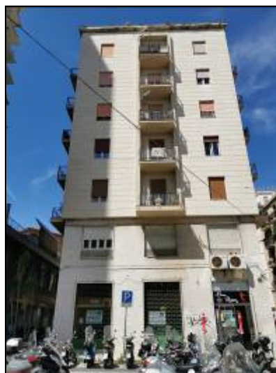
Prospetto laterale dell'edificio su piazzetta Francesco Napoli
