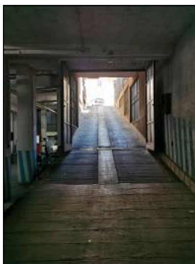
Rampa carrabile di accesso da via Ribera
