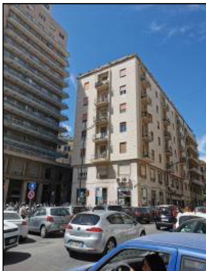
Edificio di via Ferdinando Li Donni n. 7
