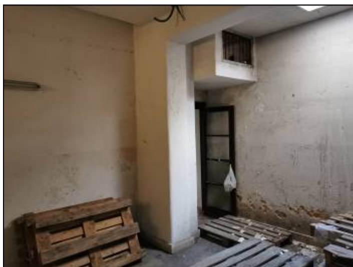
Porta di collegamento tra i due vani che compongono l'unità immobiliare
