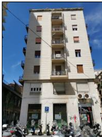
Prospetto laterale dell'edificio su piazzetta Francesco Napoli
