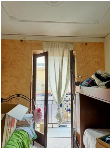
Vano al 3° piano (ex cucina)
