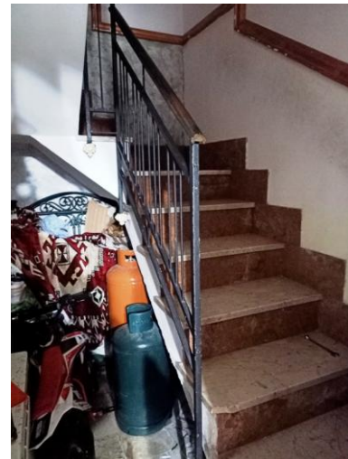
Vano scala (rampa al piano terra)
