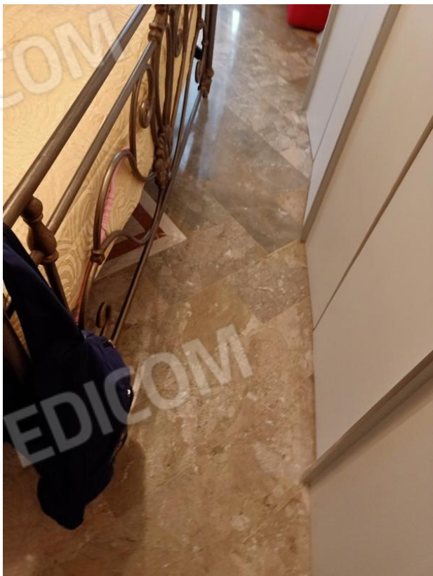
Foto n°11 – camera al 2° piano
