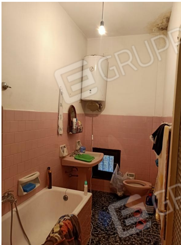
Foto n°12 - bagno al 2° piano
