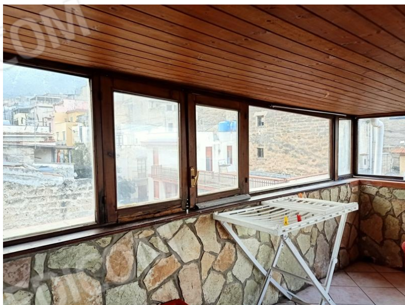
Foto n°19 – veranda abusiva sul terrazzo
