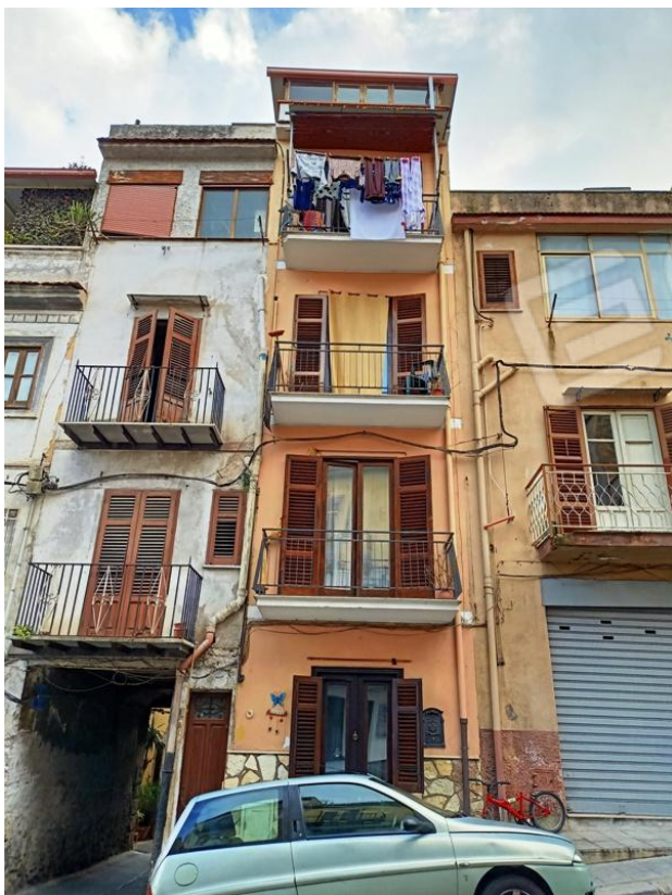
Facciata su via Garibaldi
