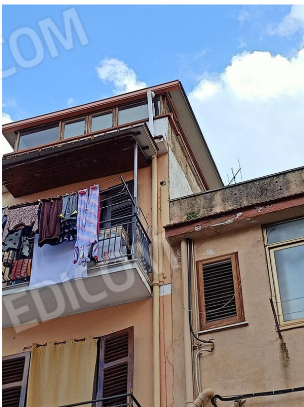
Vista della veranda all'ultimo piano
