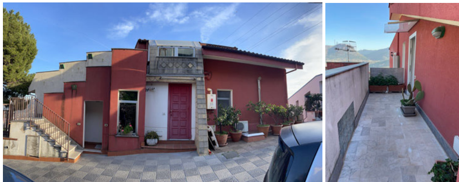
Foto n. 2/7(cfrall2) esterno-fabbricato con scala di accesso all'immobile e passetto esterno di ingresso
