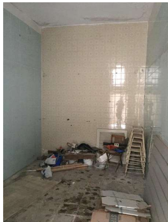
Vano ex p.lla 579 sub 6 (oggi sub 20)
