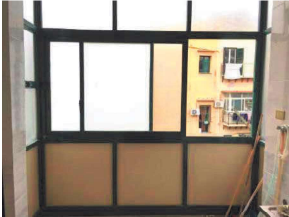
U.i. "B.2"- Veranda 2° piano (da dismettere)
