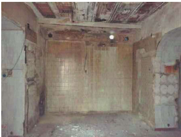
U.i. "B.3"- Vano ex pozzo luce (da ripristinare)
