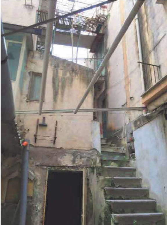
Scala esterna di accesso al 1° piano dalla corte
