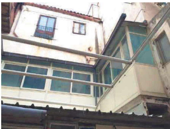
Balcone verandato sulla corte (da dismettere)
