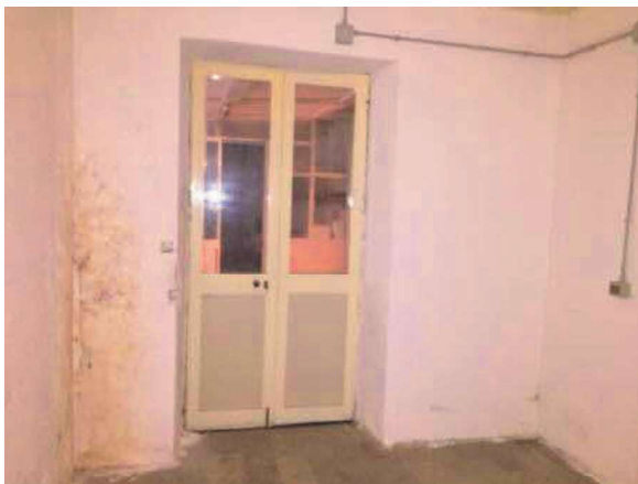
U.i. "B.2"- Vano con ingresso dalla corte comune
