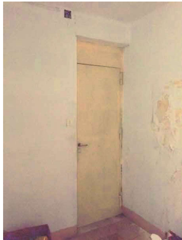
Ingresso immobile "A" dal vano scala
