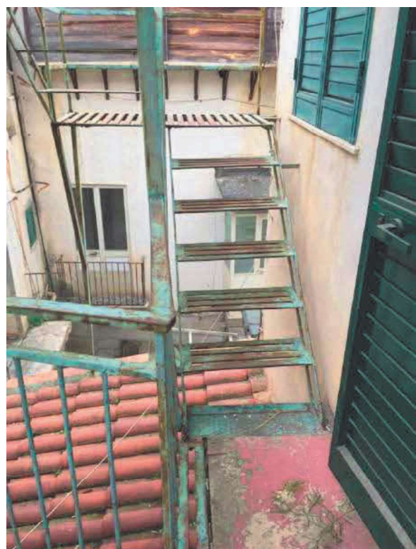
Scala esterna di accesso dalla corte al 2°-3° piano
