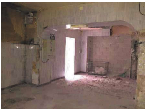
U.i. "B.3"- Vano preesistente
