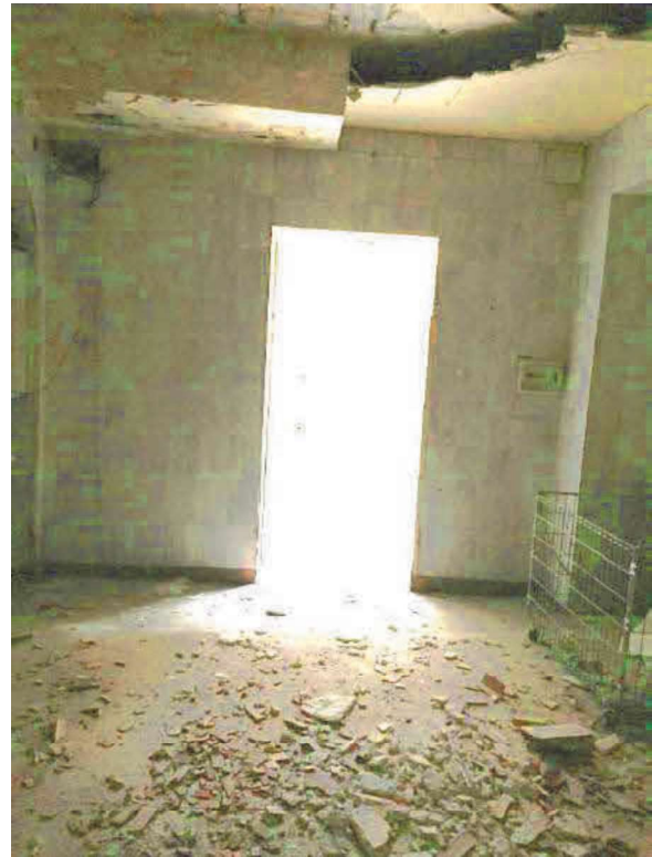
U.i. "B.3"- Vano ex pozzo luce (da ripristinare)
