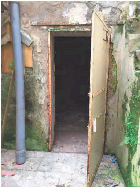
U.i. "B.3"- Ingresso dalla corte comune
