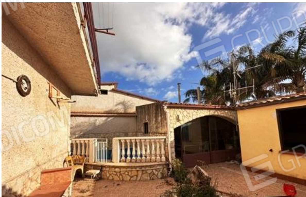
Foto n. 4 - Retrospetto e secondo corpo accessorio.
