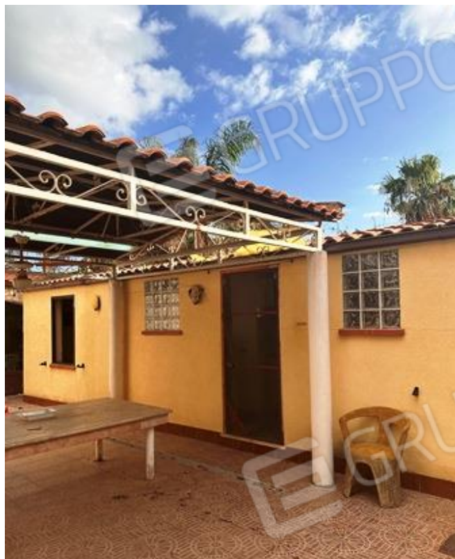
Foto n. 3 - Prospetto laterale dell'unità immobiliare, oltre il corpo accessorio
