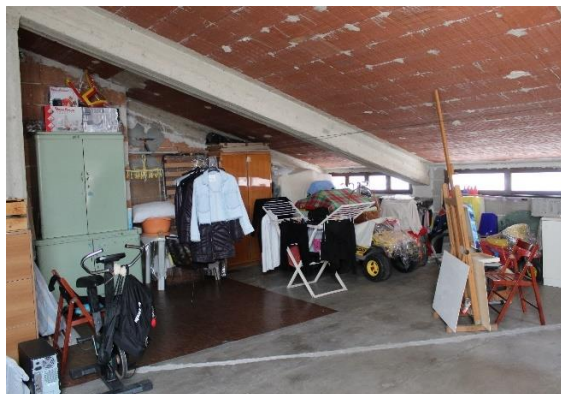
Vista della porzione di sottotetto non rifinita
