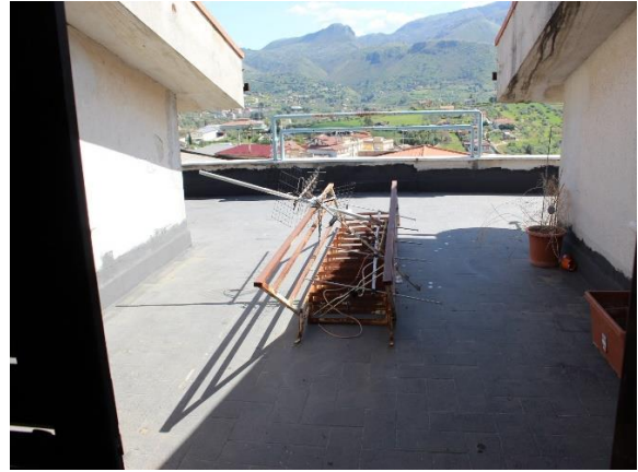
Vista della terrazza comune con il lotto n. 7
