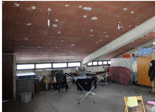
Vista della porzione di sottotetto non rifinita
