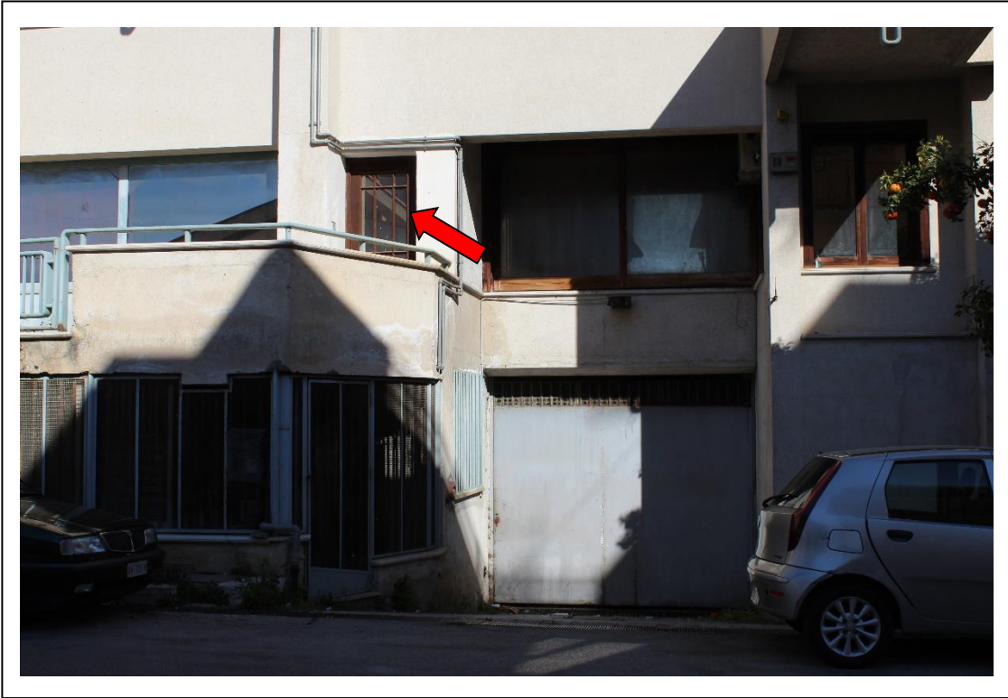
Foto dell'edificio – Portoncino di ingresso al civ. 31 sulla rampa di via Mazzini
