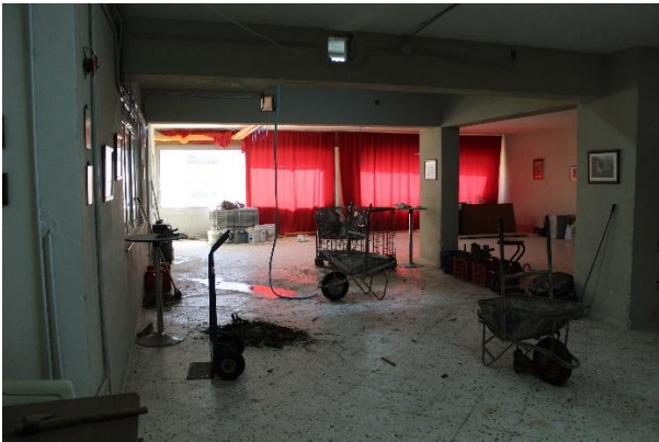
Vista del locale pilastrato
