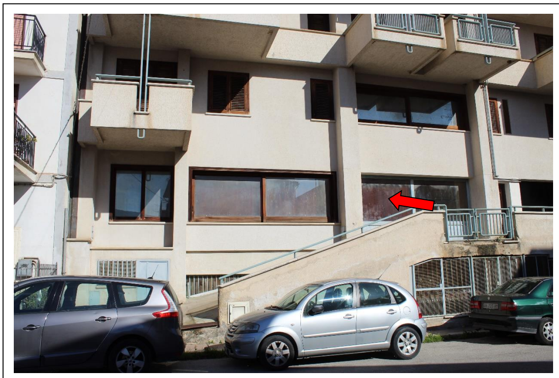
Foto dell'edificio – Individuazione del locale commerciale
