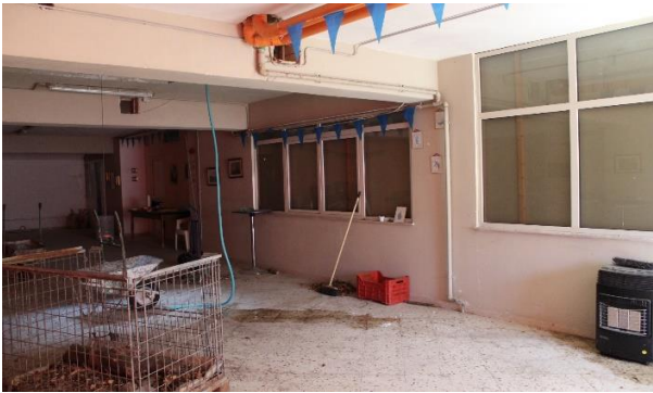
Vista del locale pilastrato
