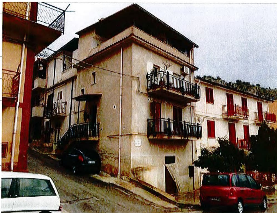
Foto 1: Prospetto esterno principale
