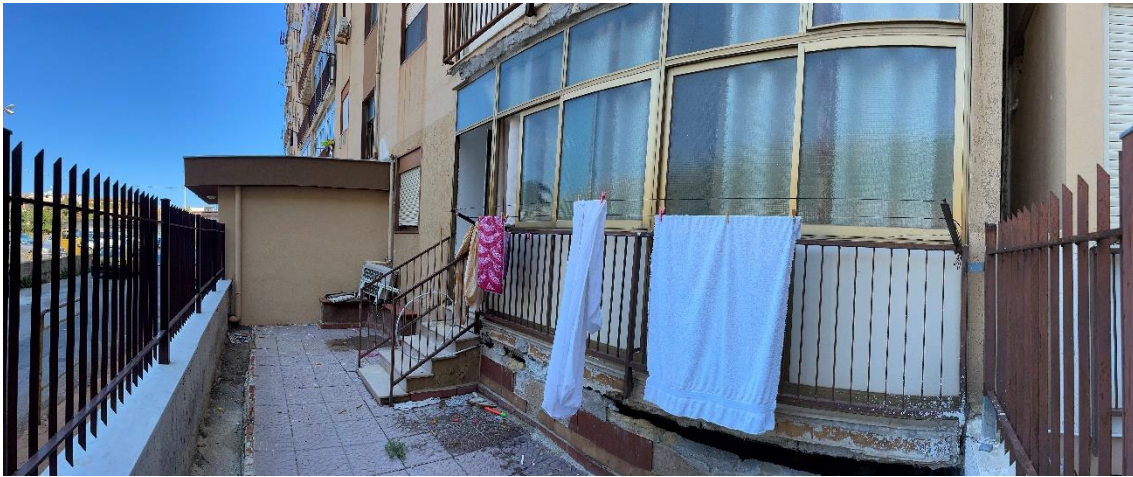
Corte esterna di pertinenza prospetto sud
