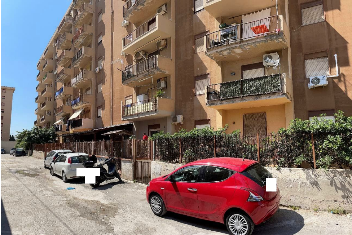
Vista prospetto secondario da Via Carlo Lorenzini Collodi
