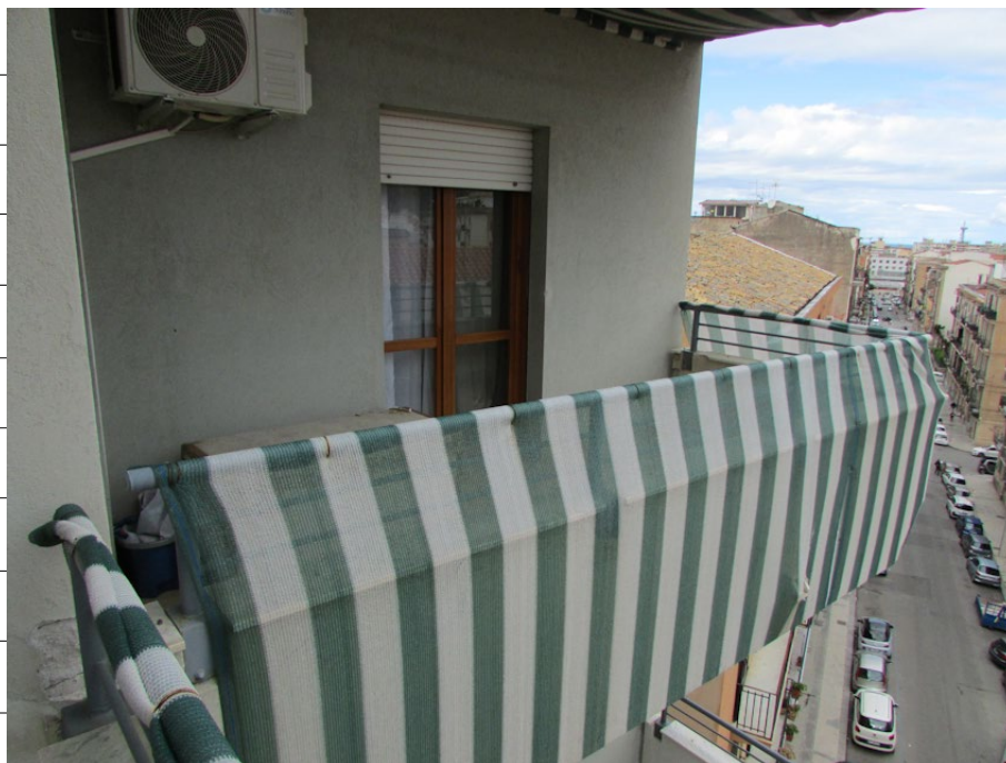
Figura 16: Particolare del balcone della camera "Letto 2", indicato in planimetria come "Balcone 3".
