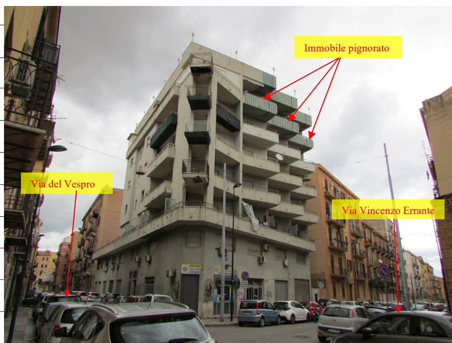
Figura 4: Ripresa dall'angolo tra la via del Vespro e la via Vincenzo Errante dell'edificio nel quale è ubicato l'immobile oggetto di stima (indicato in figura).
