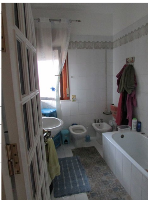
Figura 18: Particolare del servizio igienico indicato come “WC 2” in planimetria.
