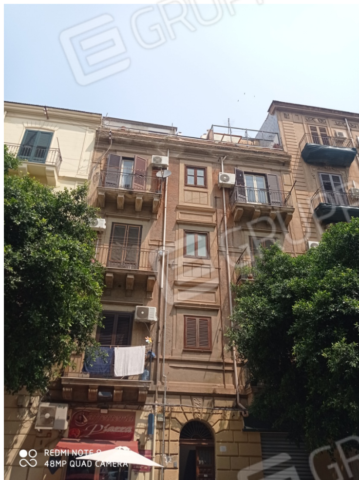
Foto 1. Veduta della facciata su via Juvara
