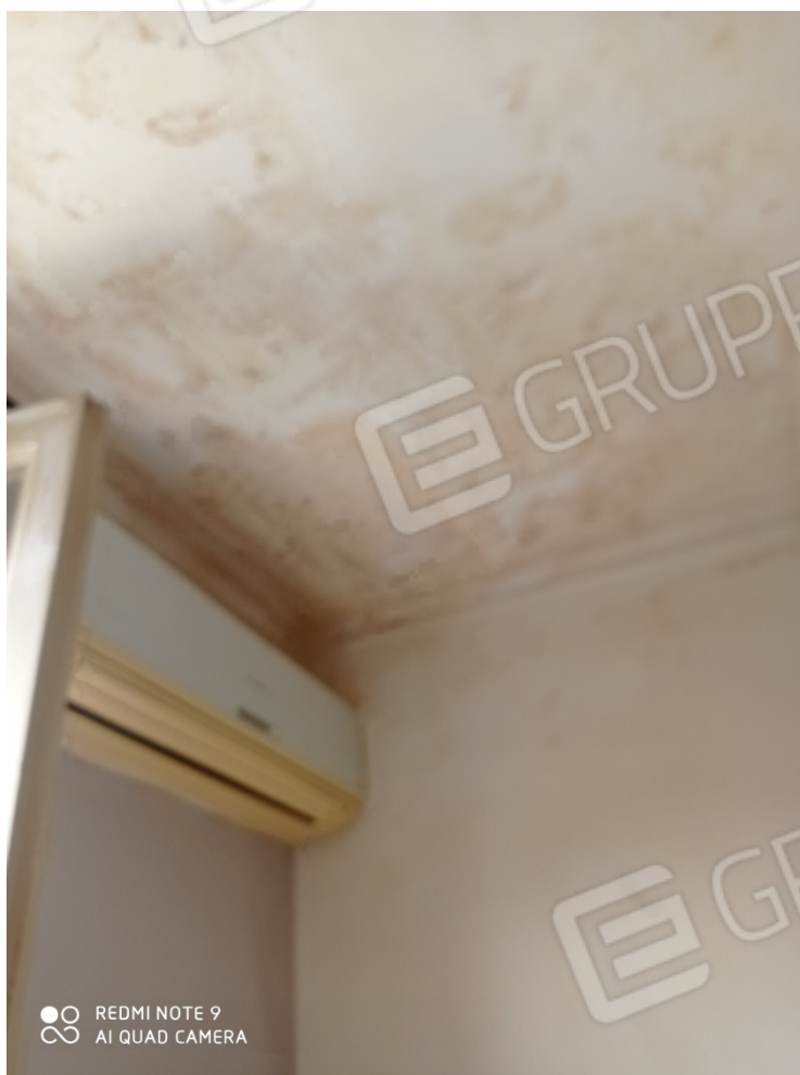
Foto 8. Tracce di umidità nel solaio in corrispondenza del pluviale rotto
