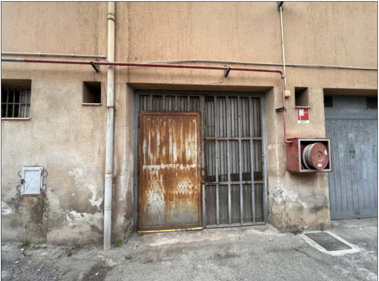
ingresso locale deposito al piano seminterrato
