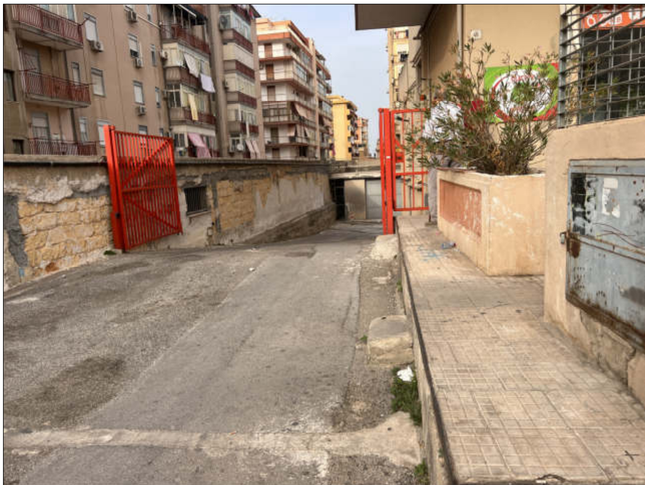
viste rampa condominiale per accesso al seminterrato
