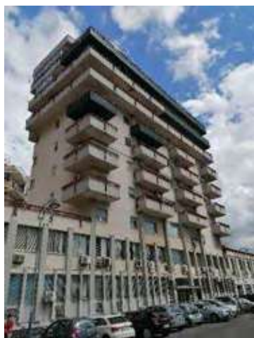
Foto 1: Vista fabbricato da via Catania
