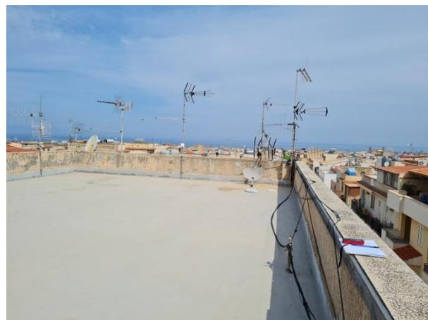
Sul terrazzo insiste la copertura a vetri della chiostрина da cui prendono luce gli appartamenti della palazzina. Il lastrico solare risulta pavimentato con guaina impermeabilizzante in mediocre stato di conservazione. Lungo il muretto sono collocate le antenne dei vari appartamenti.
