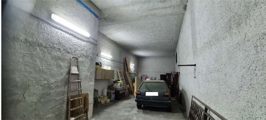
Magazzino – Interno – Corpi illuminanti - Neon
