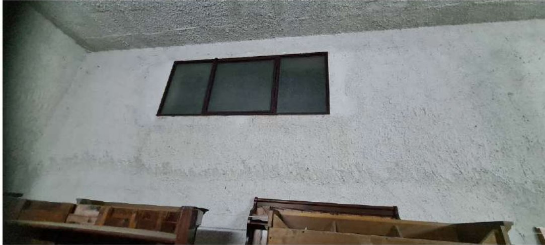
Magazzino – Particolare infissi sottotrave
