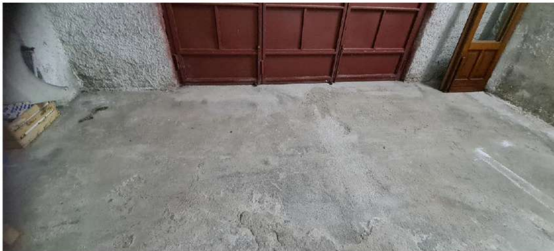
Magazzino – Pavimento in battuto cementizio
