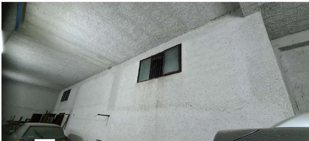
Magazzino – Infissi sottotrave
