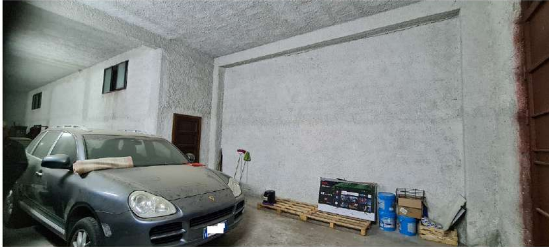
Magazzino – Pareti intonacate
