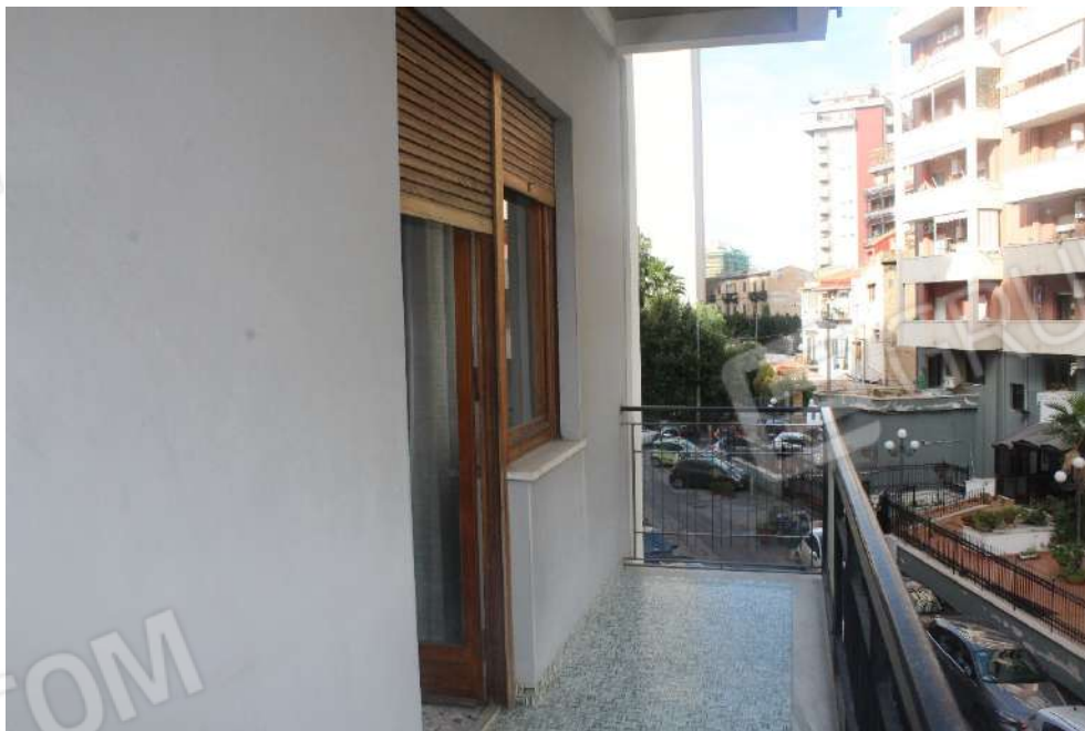
Foto n°45 – Balcone (B) esposto su prospetto laterale
