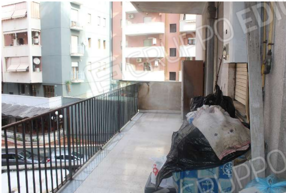
Foto n°48 – Balcone (C) esposto su retro - prospetto
