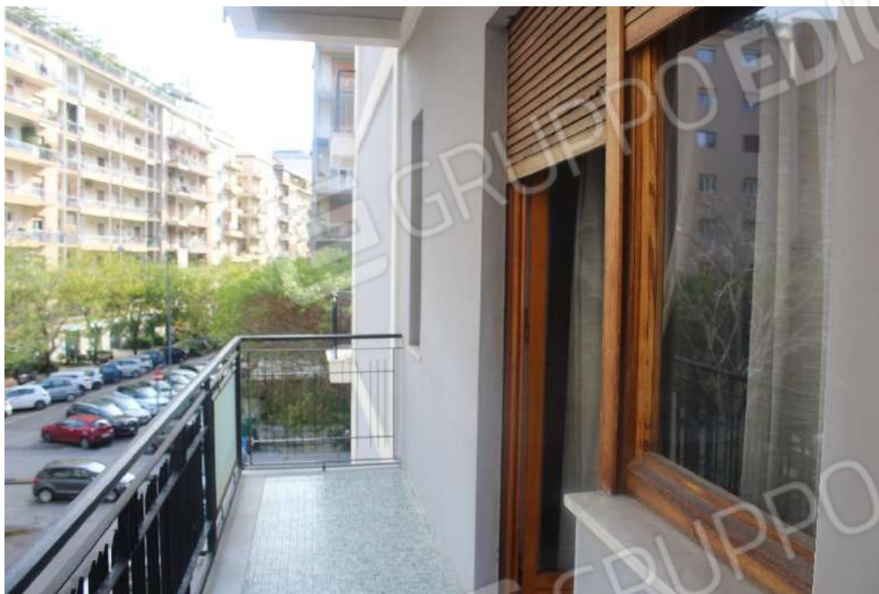
Foto n°46 – Balcone (B) esposto su prospetto laterale
