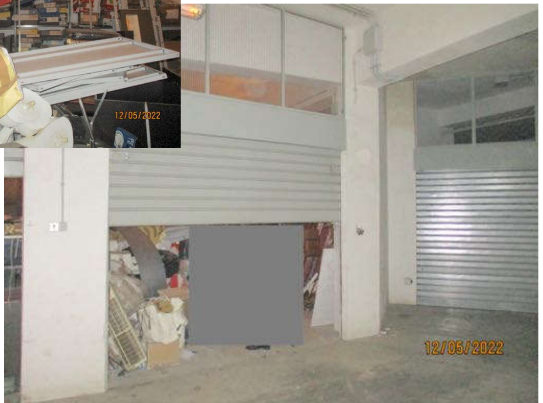
viste dell'immobile: ingresso comune carrabile esterno e locale interno
