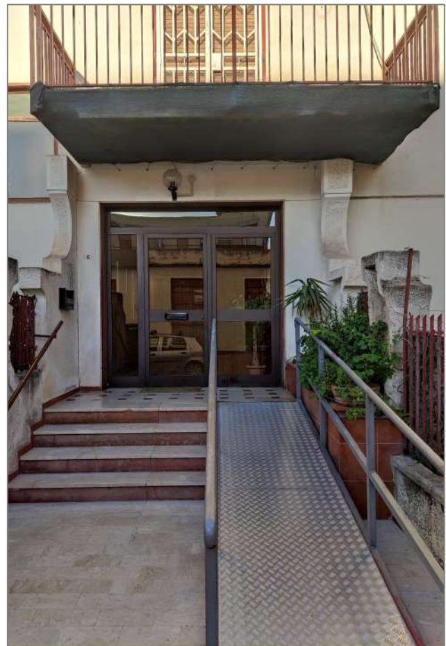
Portone di ingresso al fabbricato. Scala C
