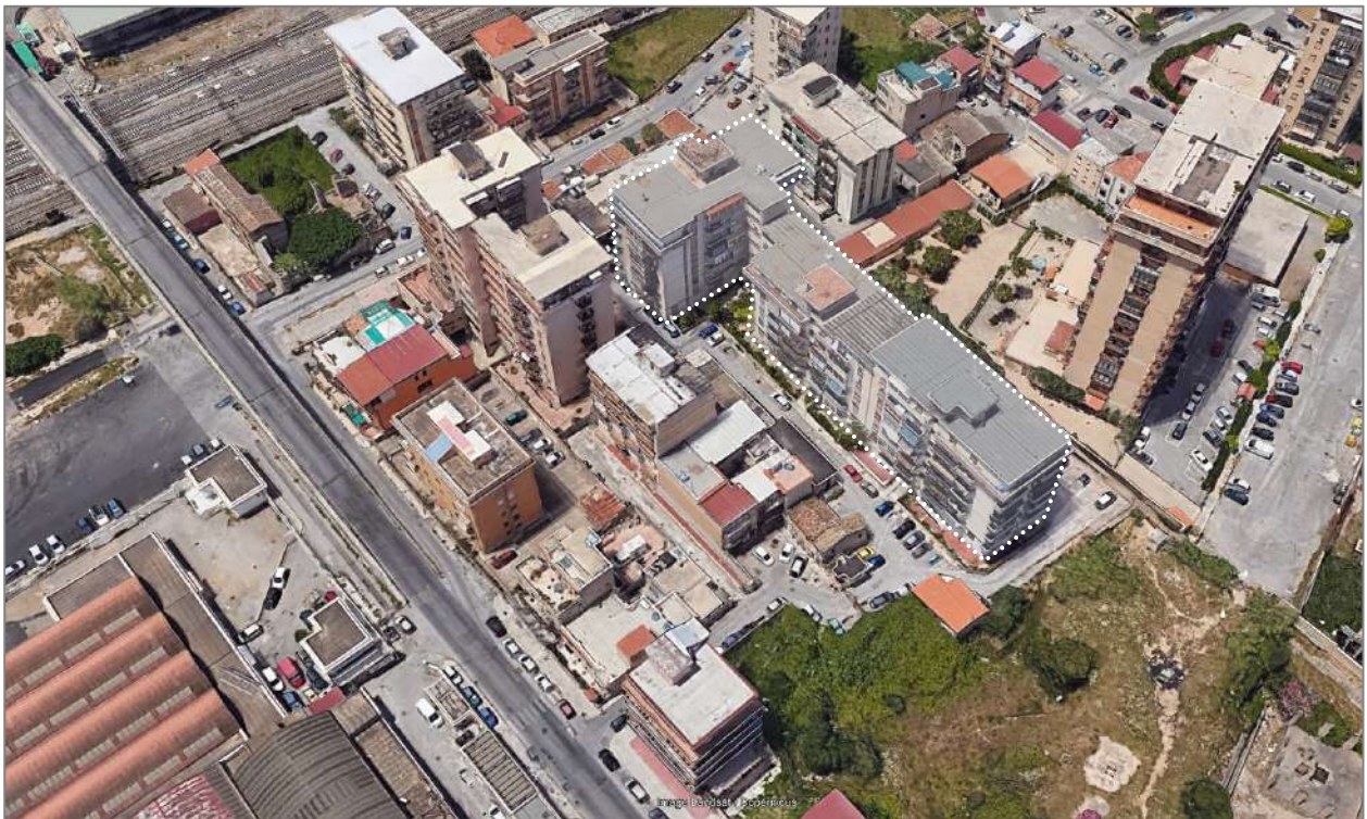
Visione d'insieme del complesso edilizio di Fondo Mortillaro 6
