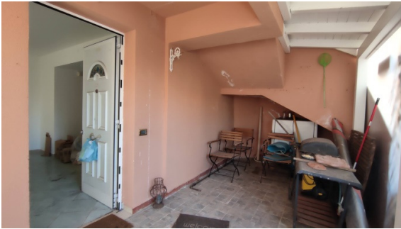
Fig. 14 zona coperta antistante il semicantinato
