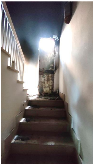
Fig. 32 scala di accesso al piano primo.
