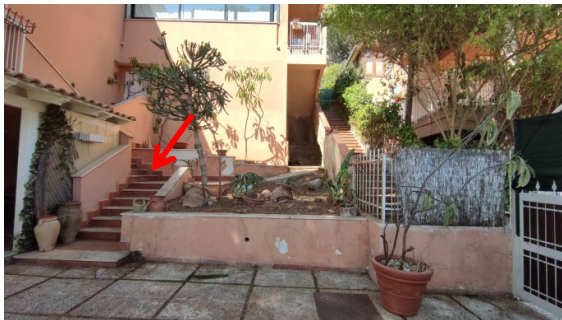
Fig. 12-13 corte comune e scala di accesso al piano superiore
